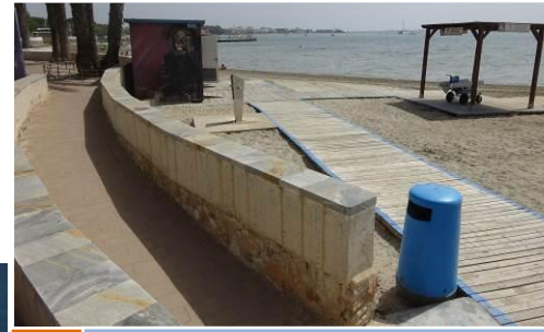
6 Rampa de acceso
