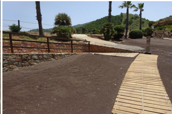
3 Rampa de acceso
