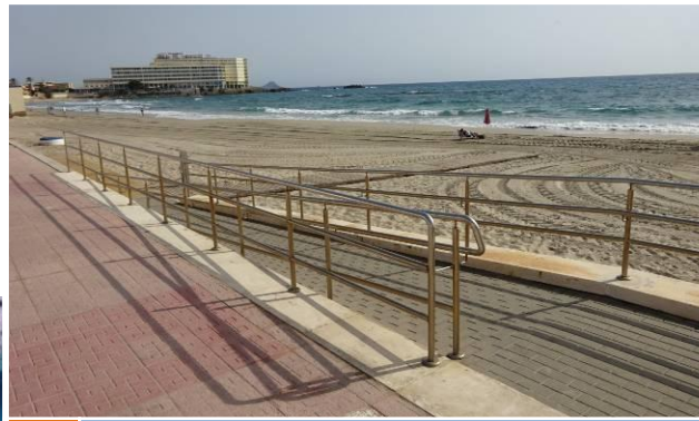
4 Rampa de acceso
