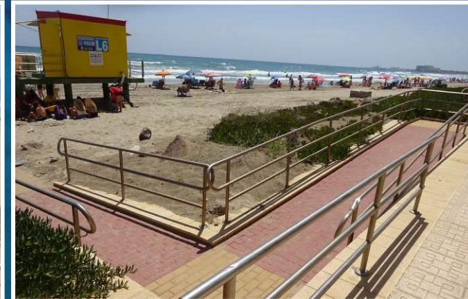
3 Rampa de acceso
