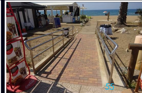
4 Rampa de acceso
