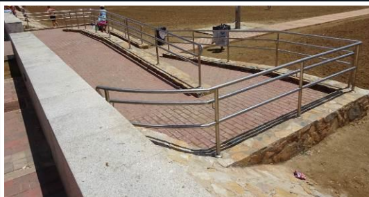
5 Rampa de acceso
