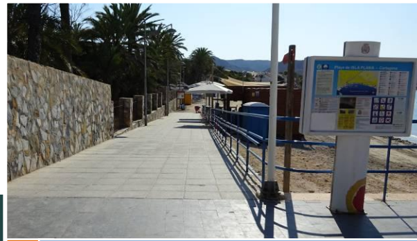
4 Rampa de acceso
