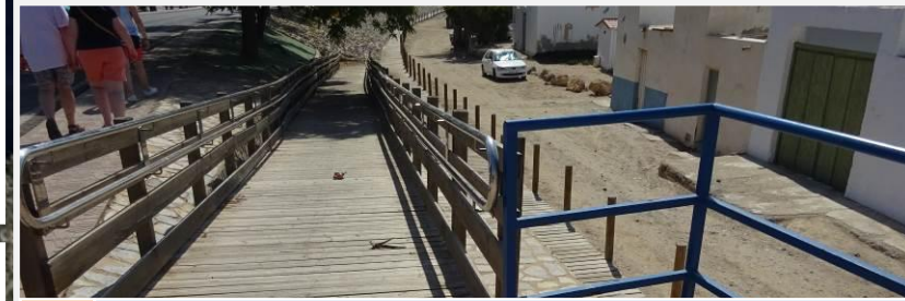
5 Rampa de acceso
