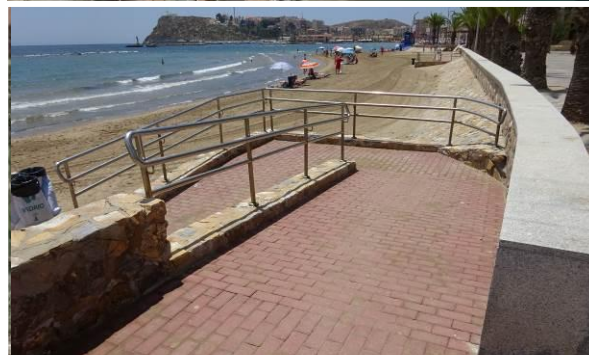
4 Rampa de acceso
