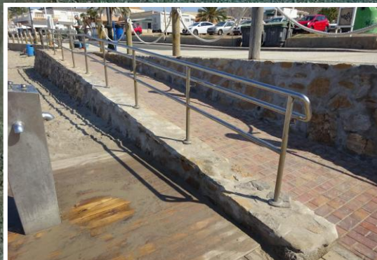
5 Rampa de acceso
