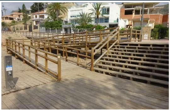
4 Rampa de acceso
