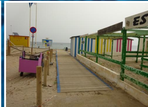
3 Pasarela de acceso
