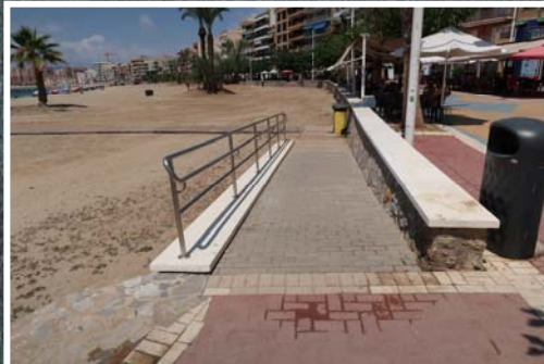
3 Rampa de acceso
