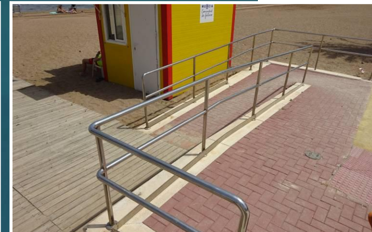
5 Rampa de acceso
