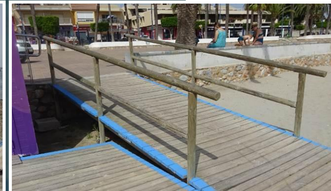
5 Rampa de acceso
