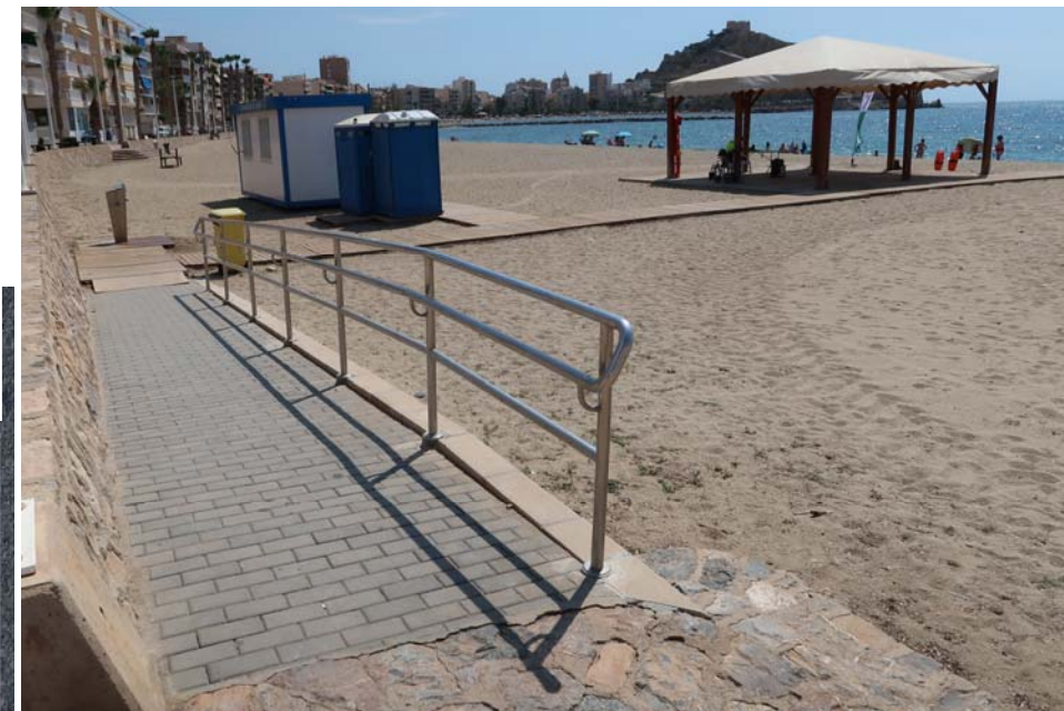
3 Rampa de acceso
